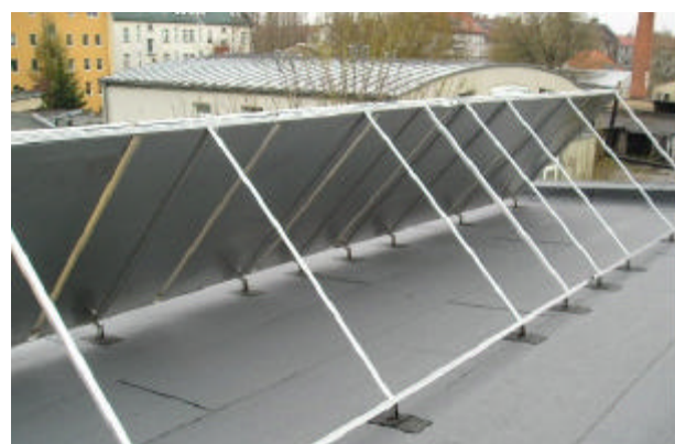
Solaranlage in einem Berliner Hinterhof , Kollektor 3000 SU , Flachdachmontage
