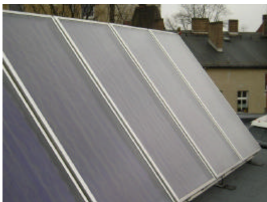
Solaranlage in einem Berliner Hinterhof , Kollektor 3000 SU , Flachdachmontage
